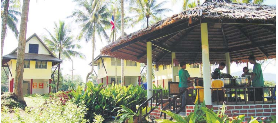
Umsäumt von einer malerischen Hügelkette mit üppiger Vegetation sind in einem kleinen Tal spitzgiebelige Wohnhäuser gebaut worden. Auf dem weitläufigen Gelände der Beluga School for Life stehen Pavillons – Lernorte, an denen die Kinder künftig unterrichtet werden sollen. FOTOS: KRISCHAN FÖRSTER
